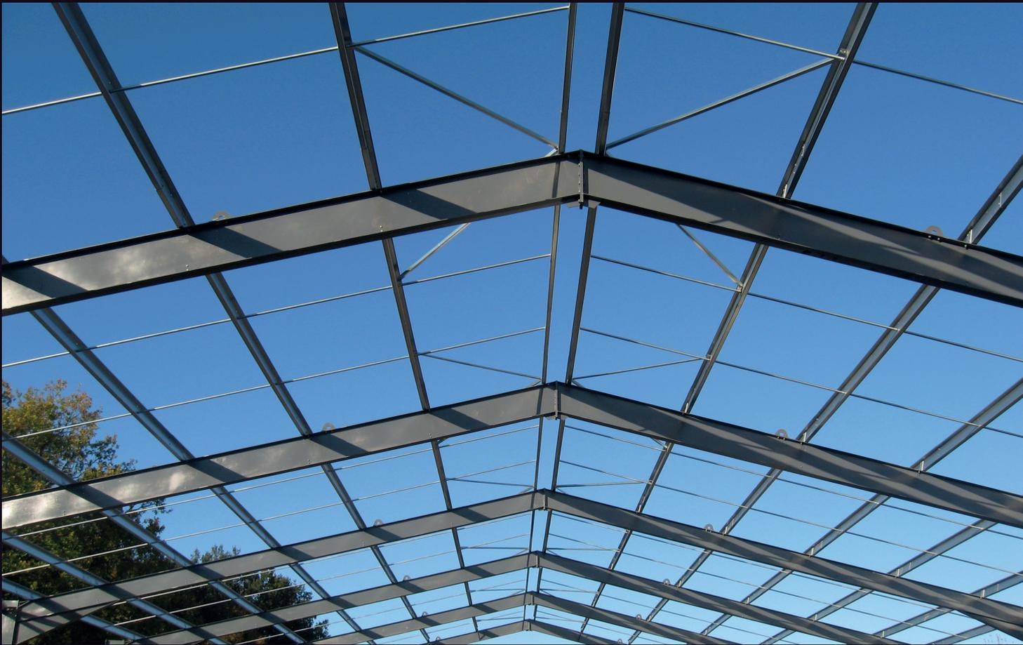
Bacacier By Kingspan vous propose une solution complète d'empannage et lissage (profilés SIGMA et accessoires), adaptée à votre chantier.
